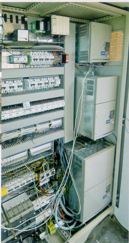
A droite: Armoire de commande avec variateurs de vitesse ATV 58 et ATV 28.
